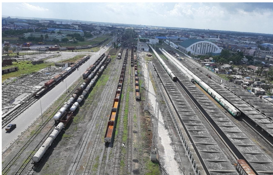
Figura 6: Vista aérea e parcial do parque industrial ferroviário da Estação da Beira.
