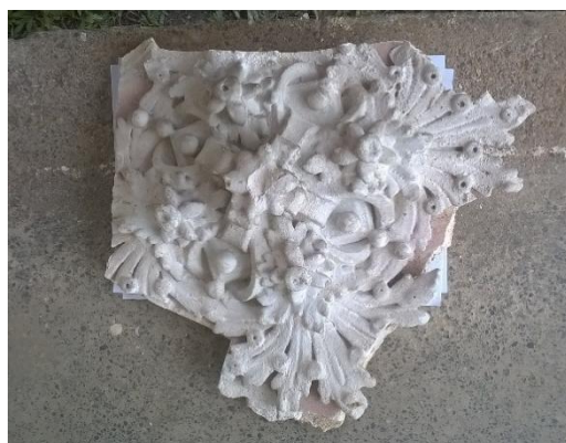
Figuras 3 e 4. Fragmento de placa estucada da capela e protótipo de placa. Fonte: Ronaldo Marques de Carvalho (2016;2017).
